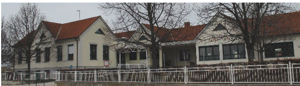
Schulkomplex der Neuen Volksschule Müllendorf
